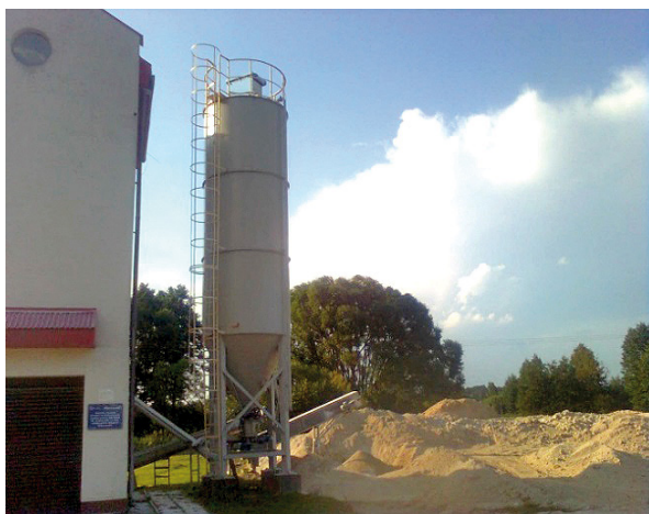
Rys. 7.6.1.2. Silos na wapno oraz podajniki granulatu na plac składowy przy oczyszczalni ścieków; Głogów Małopolski 2013 r. (źródło: [25])
