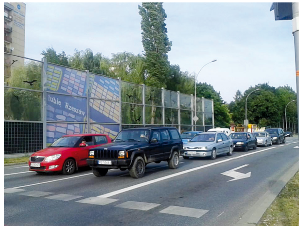
Rys. 4.3.1. Ekran akustyczny; Al. Powstańców Warszawy Rzeszów 2013 r. (źródło: [25])
