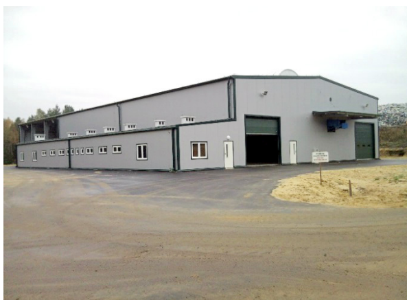
Rys. 7.1.2.3. Obiekt sortowni zmieszanych odpadów komunalnych; Sigetki, pow. niżański 2013 r. (źródło: [25])
