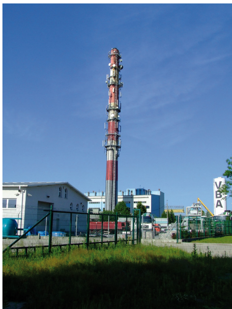
Rys. 5.1.3. Komin ciepłowni, na obiekcie zainstalowane są anteny nadawcze operatorów T-Mobile Polska S.A. Polkomtel Sp. z o.o., Aero2 Sp. z o.o., NetWorkS! Sp. z o.o., P4 Sp. z o.o.; Łańcut 2013 r. (źródło: [25])
