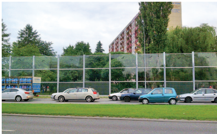
Rys. 4.3.1. Ekran akustyczny w Rzeszowie przy Alei Powstańców Warszawy, 2011 r. [28]
