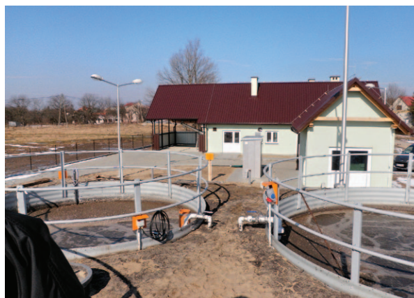
Rys. 2.2.12. Oczyszczalnia ścieków komunalnych m. Krzeszów, gm. Krzeszów, 2011 r. [28]
