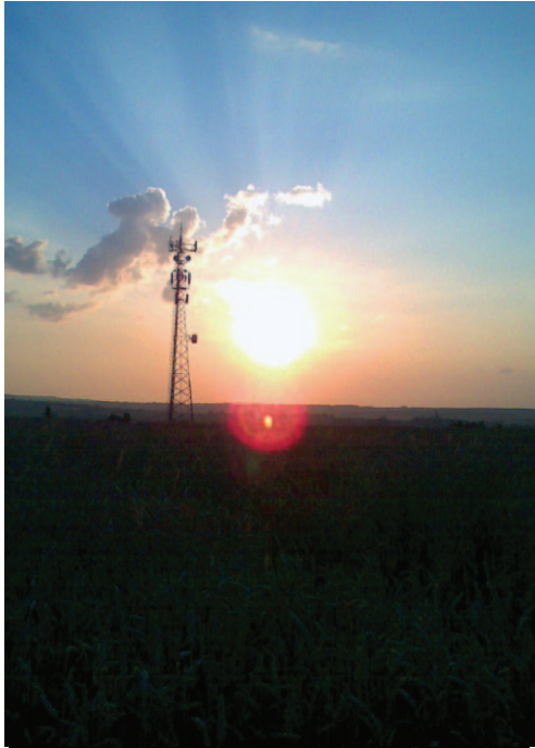
Rys. 5.1.2. Stacja bazowa cyfrowej telefonii komórkowej zlokalizowana w okolicach m. Kańczuga (powiat przeworski), 2011 r. [28]
