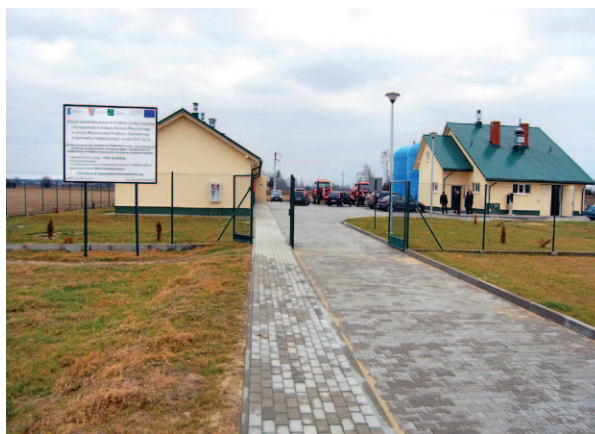
Rys. 2.6.5. Oczyszczalnia ścieków komunalnych m. Chodaczów, gm. Grodzisko Dolne, oddana do eksploatacji w 2011 r., 2012 r. [25]
