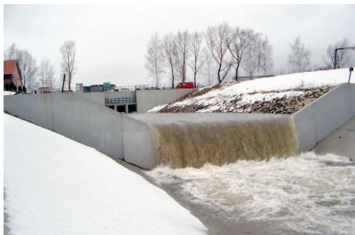
Rys. 2.5.5. Doprowadzenie wody do zbiornika, 2005 r. [21]
