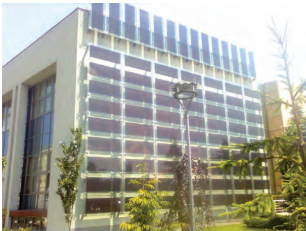
Rys. 10.4. Instalacja fotowoltaiczna na budynku WSPiA w Rzeszowie (źródło: [41])
