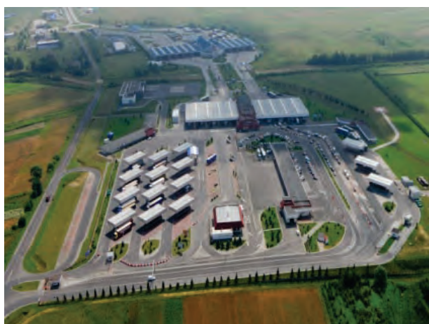
Rys. 9.3.2. Drogowe przejście graniczne w Karczowej, gm. Radymno (źródło: [30])
