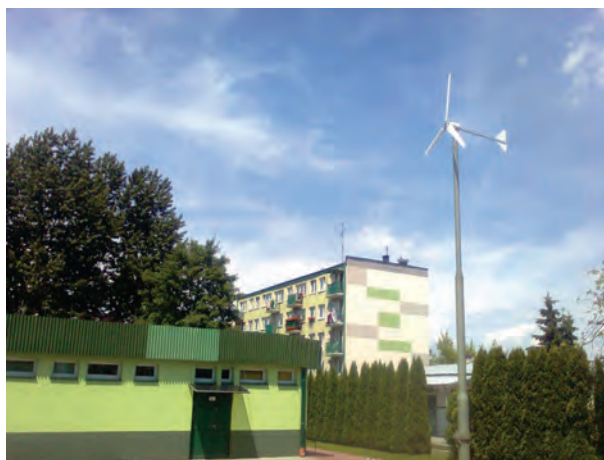
Rys. 10.8. Mini elektrownia wiatrowa w Mielcu (źródło: [41])
