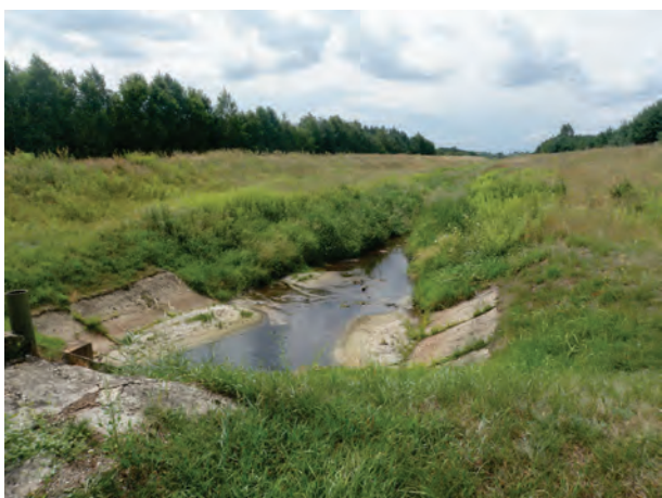
Rys. 4.1.10. Wylot kolektora ścieków z oczyszczalni ścieków w Radomyślu nad Sanem (gm. Radomyśl nad Sanem), strona prawa potoku Jodłówka, km 1+390 (źródło: [41])
