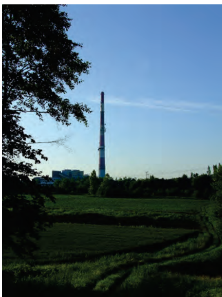
Rys. 7.1.2. Komin elektrociepłowni w Rzeszowie z zainstalowanymi antenami nadawczymi (źródło: [41])
