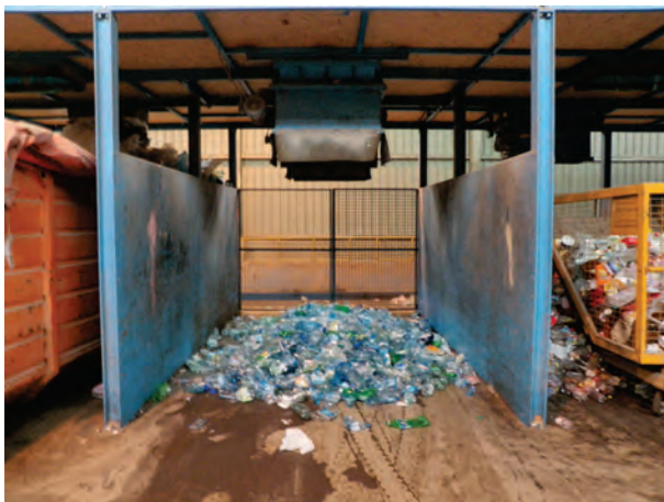
Rys. 8.1.1. Boksy na wysortowane odpady w sortowni eksploatowanej przez Miejskie Przedsiębiorstwo Gospodarki Komunalnej Rzeszów Sp. z o.o. (źródło: [41])
