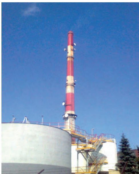
Rys. 2.1.1. Emitor energetyczny PGE Elektrociepłownia Rzeszów S.A. (źródło: [41])
