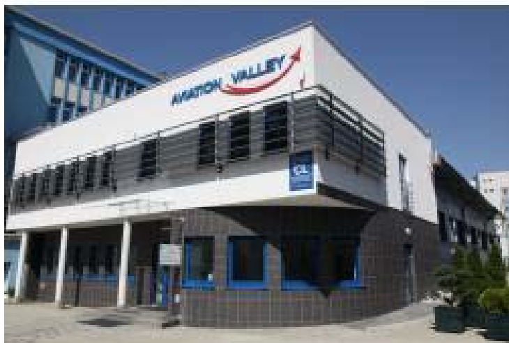
Rozbudowa nowoczesnego Laboratorium Badań Materiałów dla Przemysłu Lotniczego Program Operacyjny Innowacyjna Gospodarka wartość projektu: 38 953 989.97 zł
